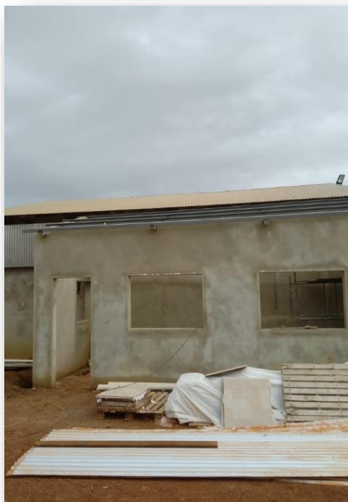
← Refeitório da Fazenda Córrego Fundo- Bom Jesus- Água Boa – MT (Obra realizada em 2022).
