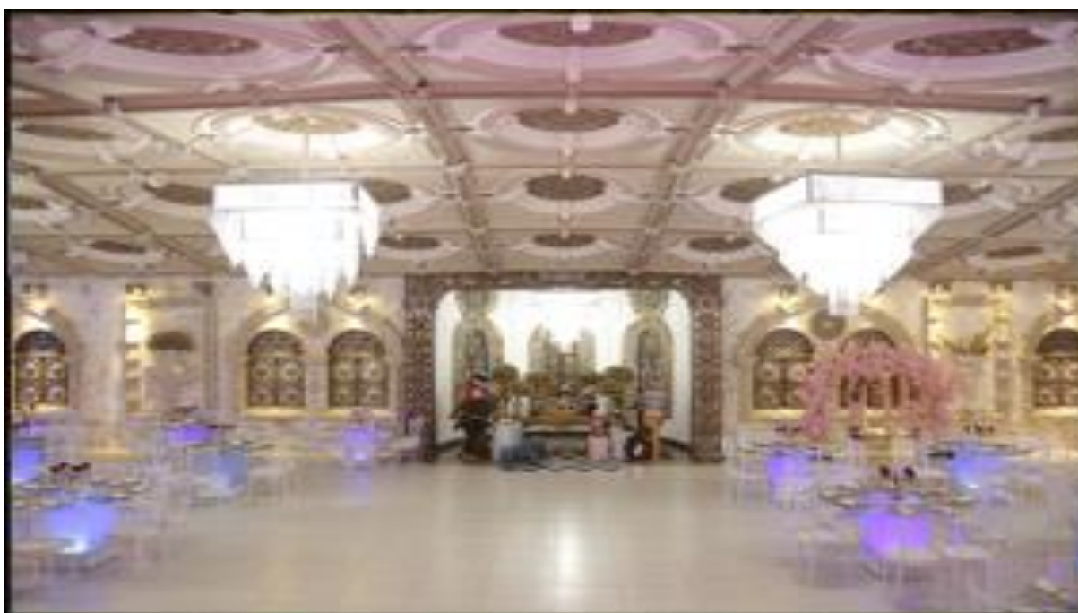
FOTO Nº 36 – DETALHE AMPLIADO DOS LUSTRES, COM DESTAQUE PARA O REVESTIMENTO DOS TETOS COM PAINÉIS DECORATIVOS MOLDADOS DE MODO ARTESANAL EM RESINA E INSTALADOS INDIVIDUALMENTE.
