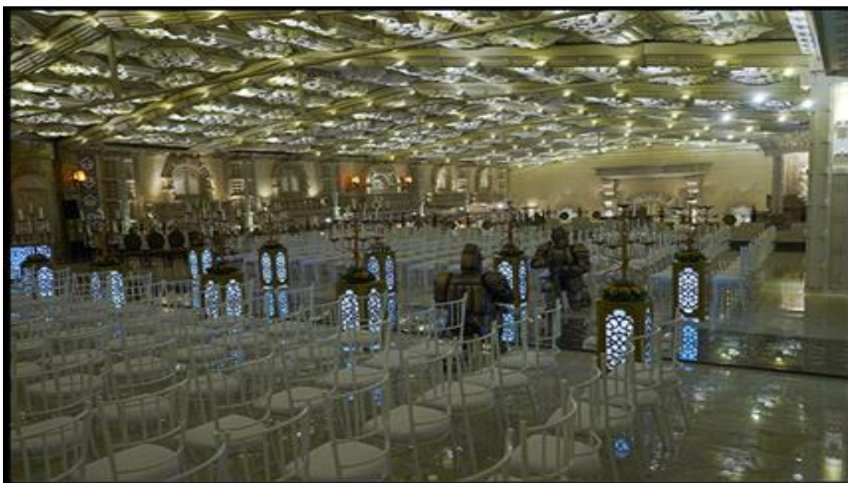
FOTO Nº 05 – DETALHE DA AMPLITUDE DO SALÃO, ONDE NÃO SE OBSERVA A EXISTÊNCIA DE QUALQUER ELEMENTO DE SUSTENTAÇÃO INDIVIDUAL NO VÃO, APOIOS SOMENTE PERIFÉRICOS, OBSERVANDO-SE O SISTEMA DE ILUMINAÇÃO, PARTE INTEGRANTE DA EDIFICAÇÃO, VALORIZANDO A EDIFICAÇÃO.
