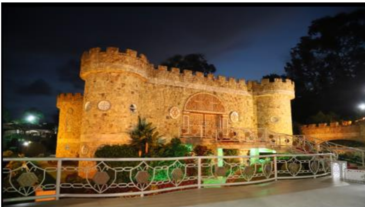
FOTO Nº 30 – DETALHE DA FACHADA LATERAL DO CASTELO DE EXCALIBUR.
