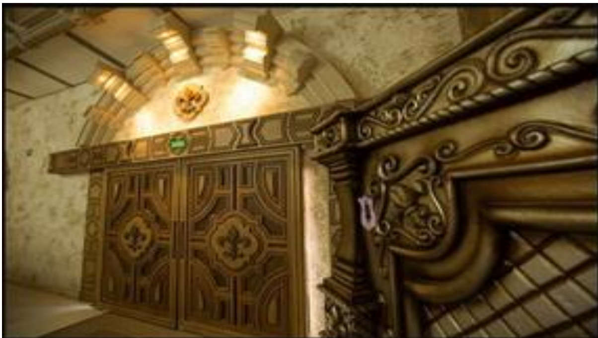
FOTO Nº 37 – DETALHE DO PORTAL DE ACESSO DECORADO COM ELEMENTOS SOBREPOSTOS AOS PAINÉIS DE MADEIRA.
